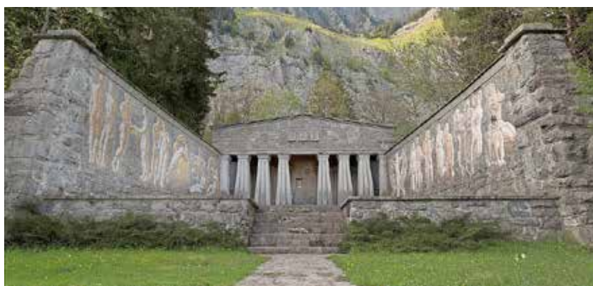
Friedensdenkmal: Ein Vierteljahrhundert lang arbeitete Karl Bickel an seinem Lebenswerk.
