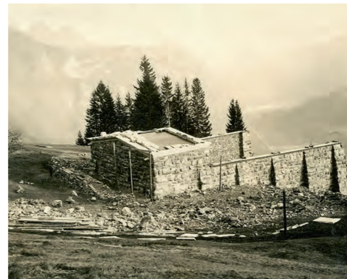
Das Paxmal im Bau.
